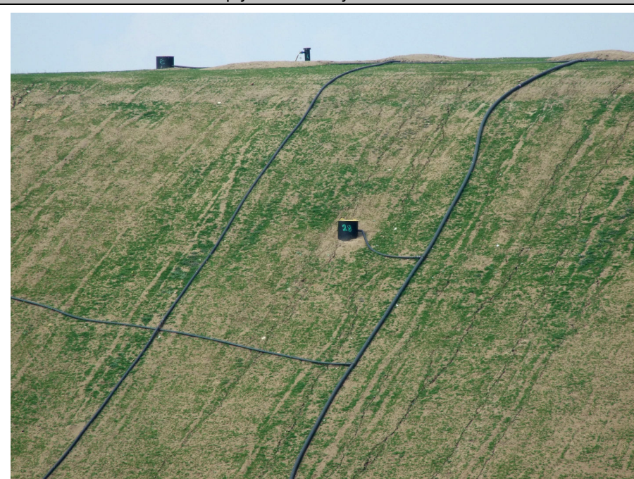
Obrázek 43: Povrchové odplynění skládky v Žabčicích
